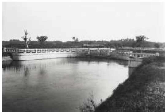
柴山伏越（昭和の改修後）
