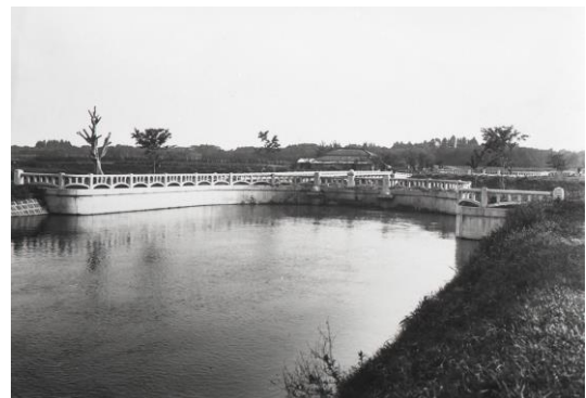
柴山伏越(昭和の改修後)
